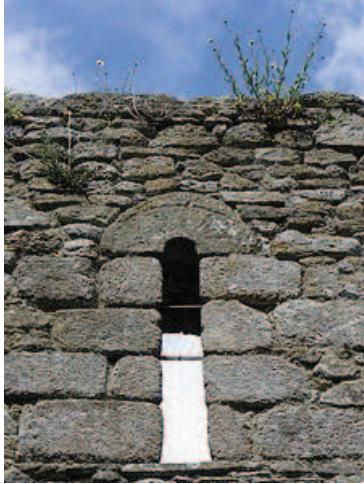
Fenêtre romane en haut du mur sud de la nef.
