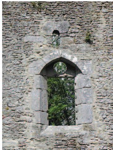
Fenêtre gothique en partie basse du mur sud du chœur.
