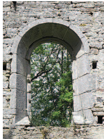
Fenêtre moderne en partie basse du mur sud de la nef.
