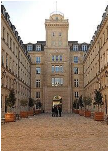
• Tour Chappe à Paris, 103 rue de Grenelle ( 7 e arrondissement ).
